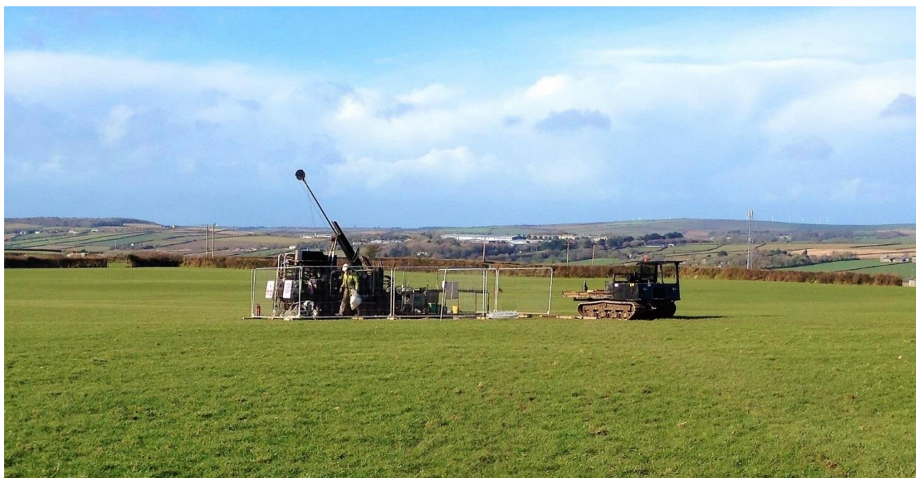
Figur 2 Borrhållsaggregat, borrhållsaggregatförvaring och avspärrning.
